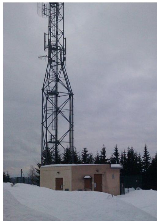
Illustration 3: Relais radio éloigné, avec intervention de maintenance en raquettes à neige
