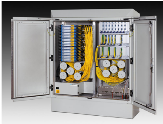
Exemple d'armoire où la zone de gestion des surlongueurs réduit la capacité de l'armoire.
