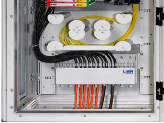
Exemple d'armoire avec zone de 4U pour entrées de câble et 4U pour gestion de surlongueur
