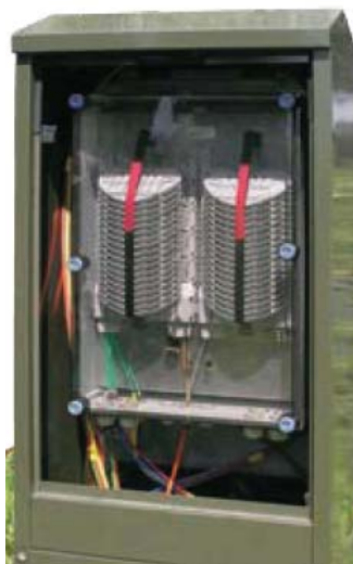
Exemple d'armoire avec boîtier étanche IP65 amovible
