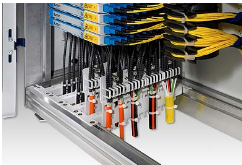
Exemple d'entrée de câble avec protection des modules de fibres par tubes flexibles.
